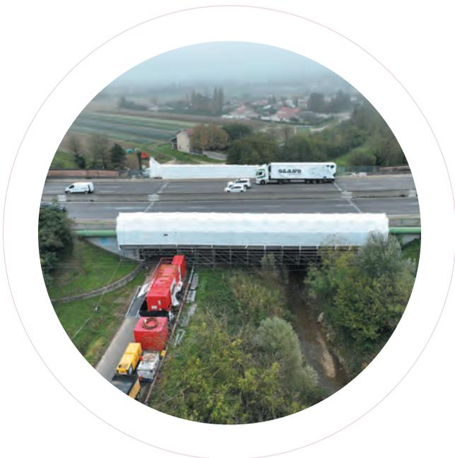
**TRAVAUX DE RÉFECTION DE LA PROTECTION ANTI-CORROSION DE QUATRE OUVRAGES D'ART SUR L'AUTOROUTE A7**
