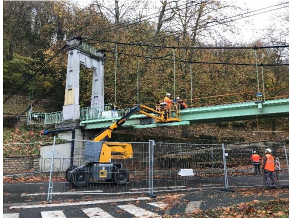
Travaux de Passerelle du Mont Olympe
