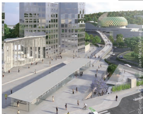
GRAND PARIS EXPRESS LIGNE 15 SUD GARE DU PONT DE SÈVRES - FRANCE
