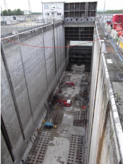
Forage d'injection dans un le sas
