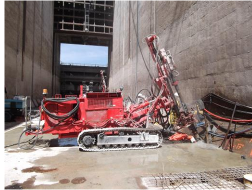
Forage d'injection dans un le sas
