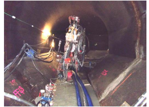
Forage d'injection dans un aqueduc
